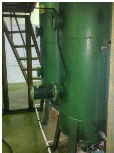
Рис. 3. Установка УЗ-агрегата на сорбционную колонну СНК-640
