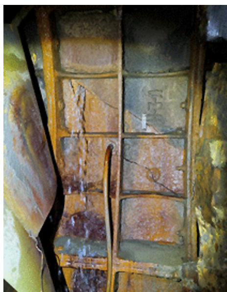
Рис. 1. Выщелачивание и мокрое пятно в межкольцевом и межблочном стыке обделки, активная течь. Трещина в спинке тубинга
