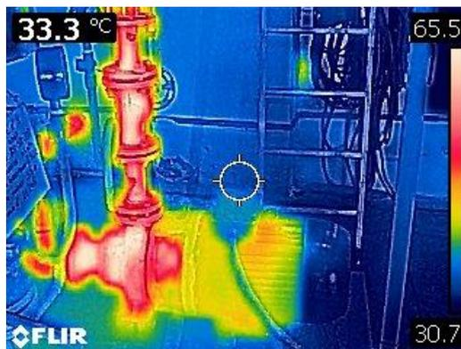
Рис. 6. Насос горячей воды – запорная арматура без теплоизоляции
