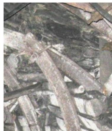
Рис. 1. Фактическое состояние западного откаточного штрека пласта  $l_2^1$  гор. 660 м (в 30 м за лавой)
