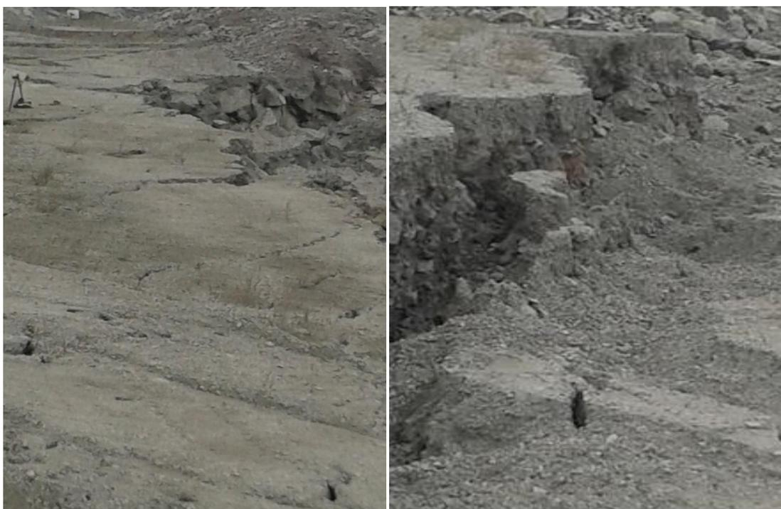
Рис. 7. Линия отрыва с оседанием площадки более 5 м на горизонте –30,0 м
